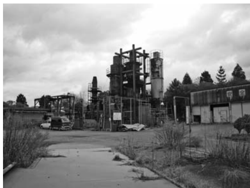
▲焼却施設撤去前
