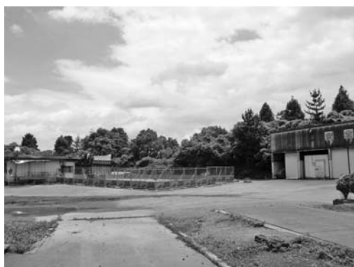
▲焼却施設撤去後
