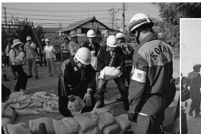
▲ 積み土のう工法で水害を防ぎます
