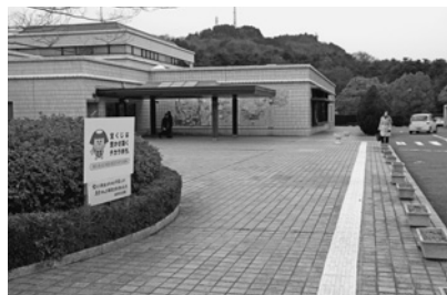
▲点字ブロックを改修（本館）
