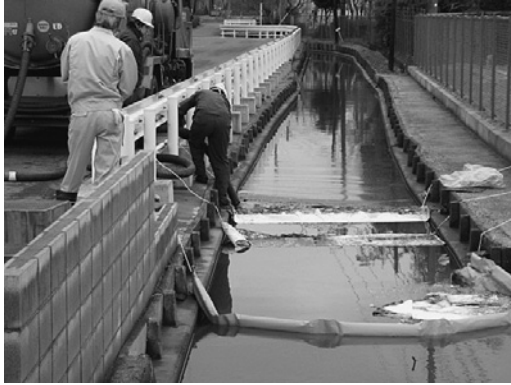
▲油類流出事故処理のため、オイルマットを設置後、バキューム車による油類回収作業実施
