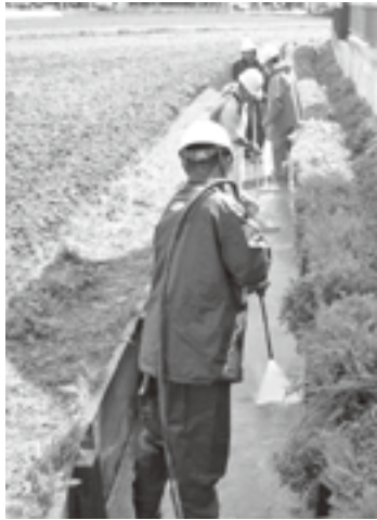
▲油が流出した水路の洗浄作業
