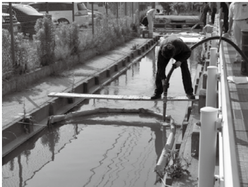
▲流出した油をせき止めての吸引作業
