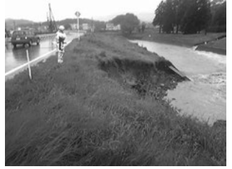
▲上砥山地先金勝川堤防
