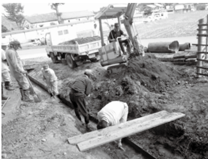
▲水路にたまった土砂の撤去
