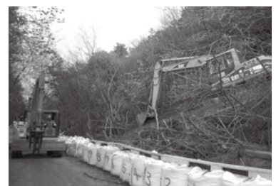
◀安養寺山北側工事
