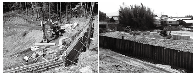
▲安養寺山治山工事(左)と金勝川災害復旧工事
