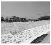
②金勝川の災害復旧工事 工事が進められています (写真は、金勝川護岸工 事<目川地先>の様子)。
