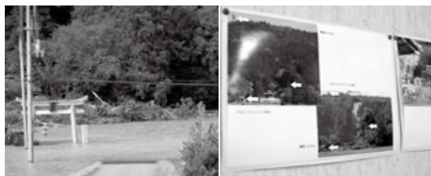
▲境内の建物がほぼ全壊した、五百井神社（左）と自治会館内に掲示されている被害と復旧状況の写真
