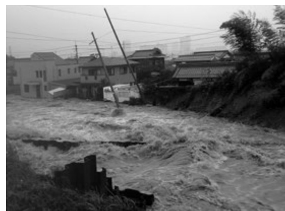
堤防が決壊し、氾濫する金勝川▶
