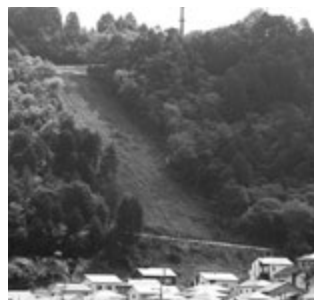
▲土砂崩れが起きた安養寺山北側
