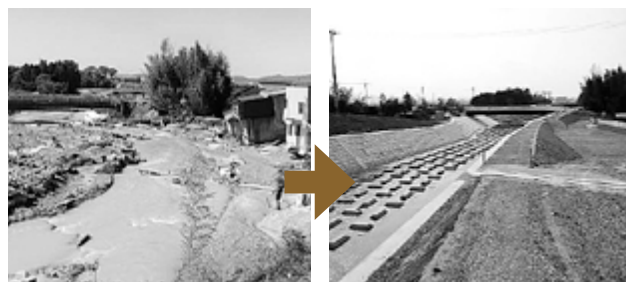
7か所で護岸が崩壊、決壊した金勝川は、平成26年8月にすべての箇所が修復されました。（復旧前[左]と現在の様子）
