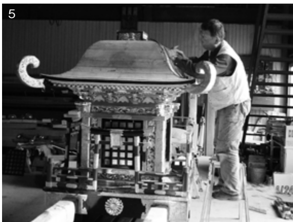
③被災から約2週間後、土砂の中からみこしを丁寧に掘り出しました④クレーン車で安全な場所に運搬⑤大人みこしを地域の職人が2週間かけて丁寧に修復
