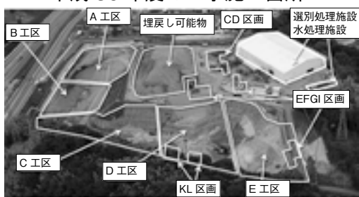
平成30年度の工事施工箇所
