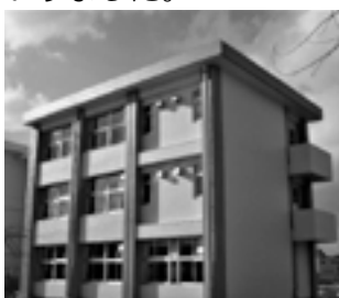
▲栗山東小学校 増築工事
