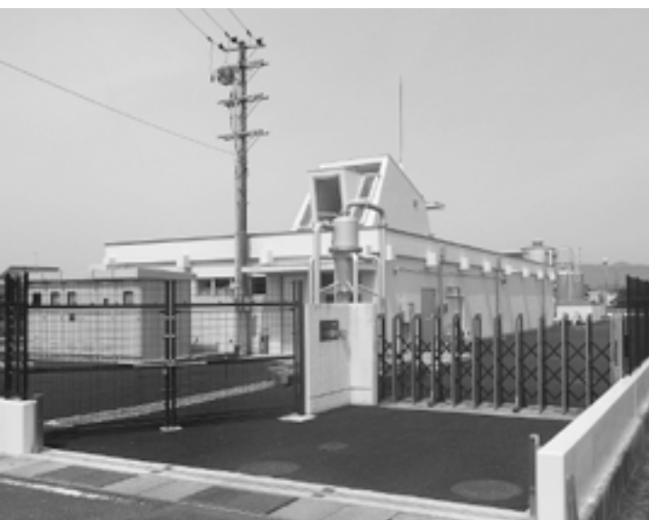
耐震化工事後の十里水源地 (令和3年6月)
