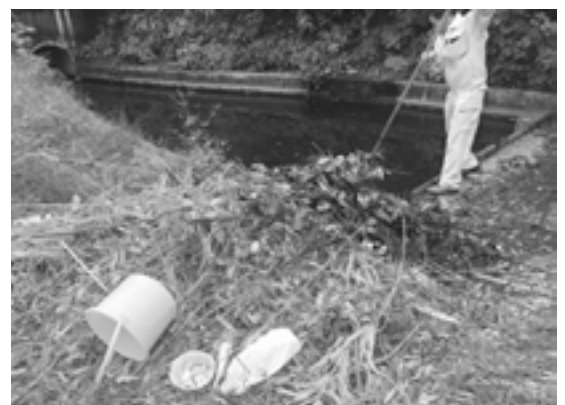
水路より上げられたごみや刈草
