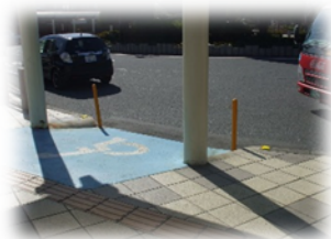
スロープの勾配の改善
