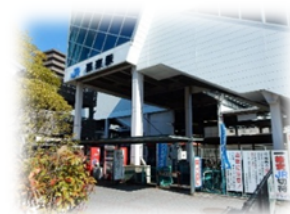
西口エレベーターの設置
