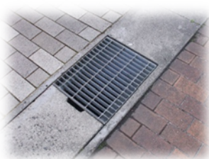
側溝蓋等の改善
