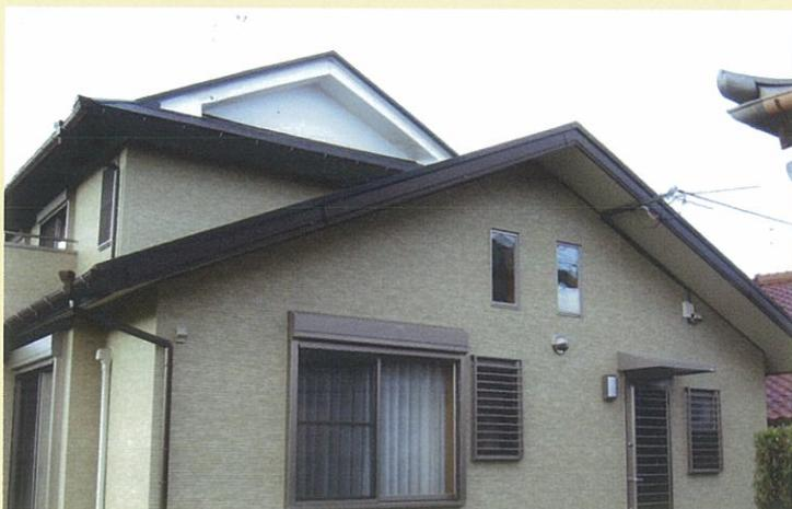
地震時に負担となる重い土葺き瓦を撤去し、地震時に有利となる軽量な平屋根スレートに葺き替え
