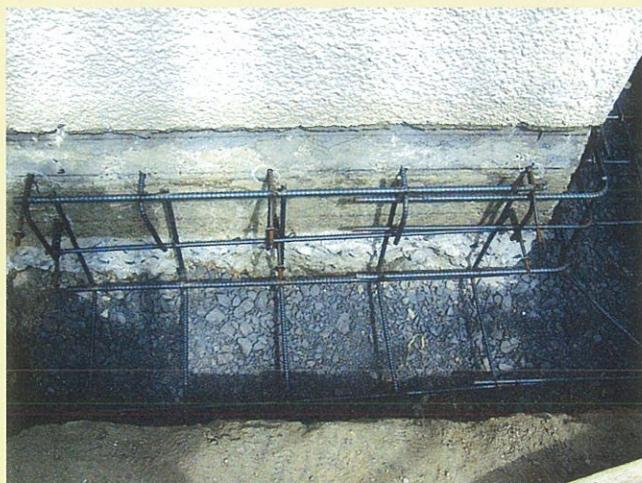
従前の基礎の外周に鉄筋コンクリート基礎による補強
