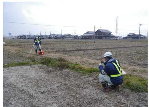
道路として必要な用地の幅を示す黄色の杭を、20m間隔または変化点に打設します。
