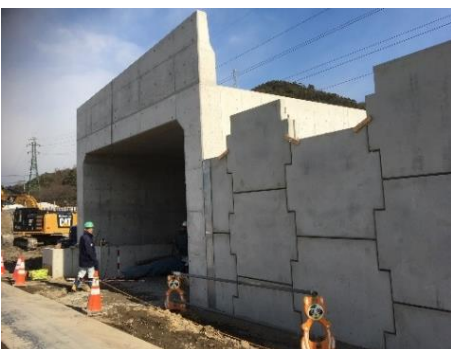
カルバート工
