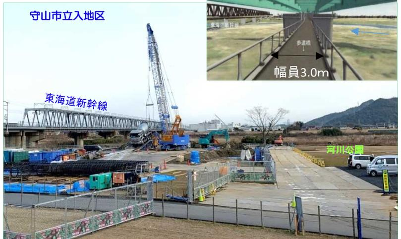
P9橋脚工事(現場打ち基礎杭施工中)
