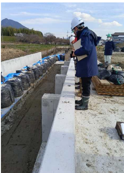
写真-5 工事現場施工状況 (下流側)
