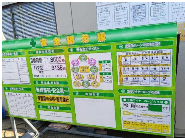
写真-12 工事標示板設置状況
