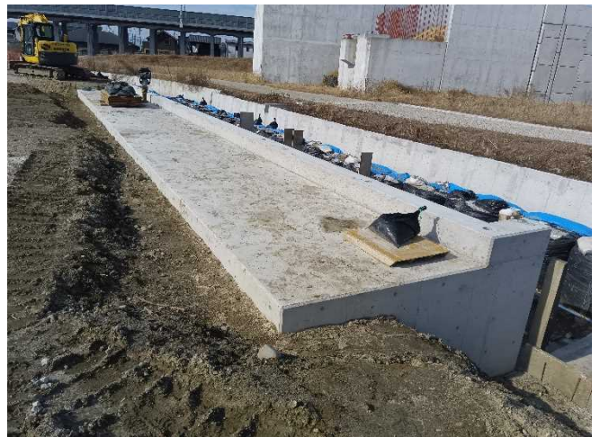
写真-4 工事現場施工状況 (下流側)
