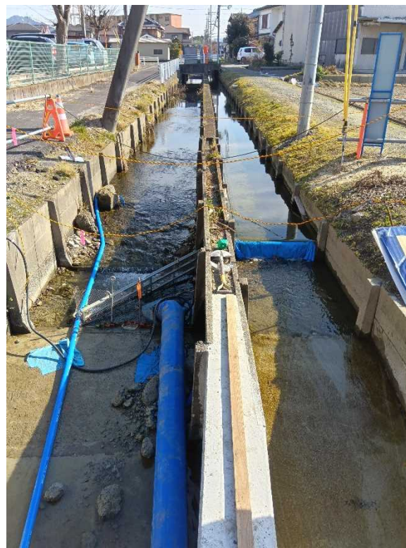
写真-9 工事現場施工状況 (既存施設への接続部)
