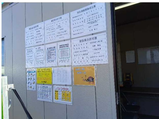
写真-11 工事標示板設置状況
