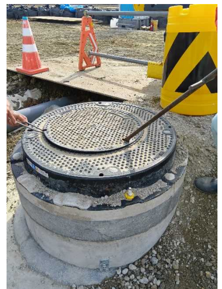
写真-7 工事現場施工状況 (特殊人孔)
