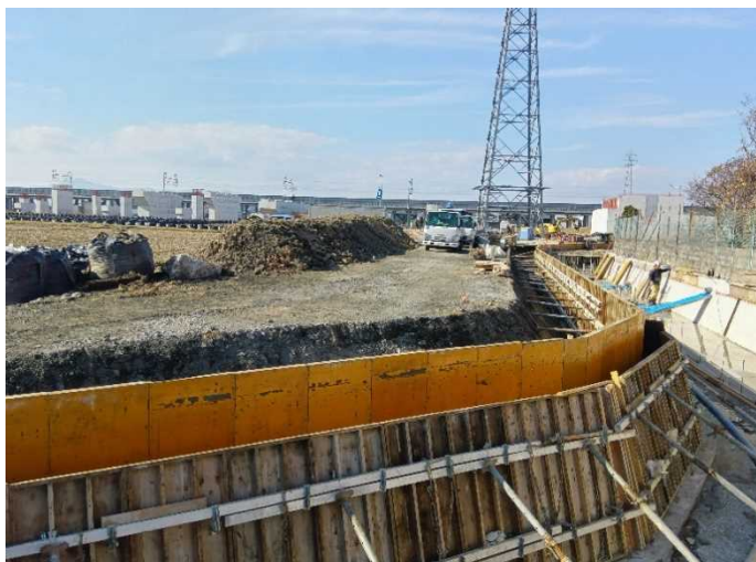
写真-8 工事現場施工状況 (上流側)
