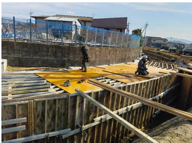
写真-10 工事現場施工状況 (上流側)
