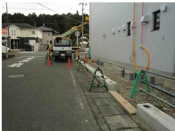
北面外構工事中（仮囲い無し）
