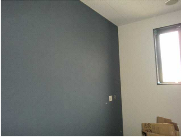
仮眠室間仕切壁
