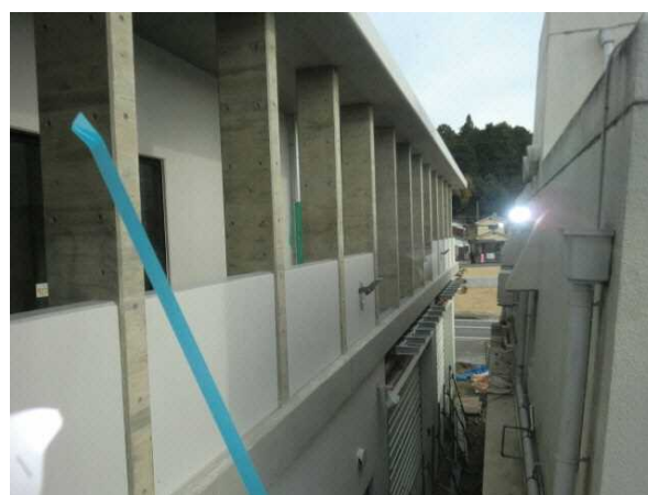
2階南面バルコニー方立、手摺壁
