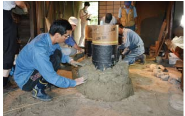
30 土積み上げ 積み上げた土は手や木鋏でならして成型 (2015.07.04 ワークショップ4日目 土積み上げ)
