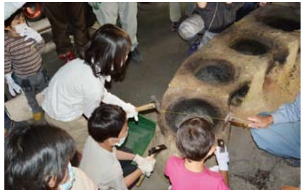
6 解体 一打目 (2015.05.23 ワークショップ1日目 解体・土づくり)
