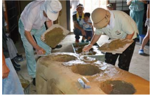
36 表面仕上げ塗り (2015.08.08 ワークショップ 6日目 表面仕上げ)
