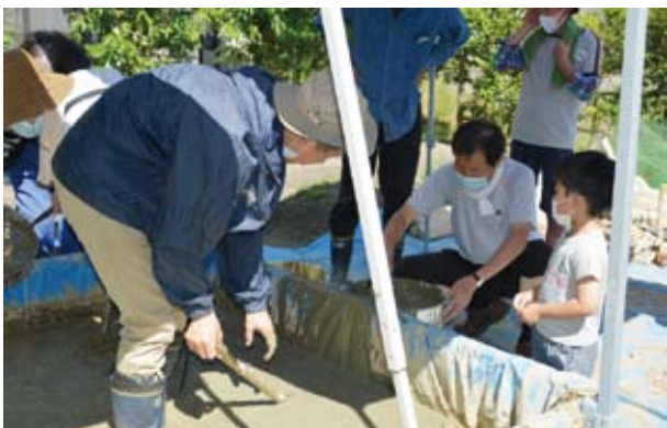
23 土づくり 表面仕上げ用の土の分離、フネから取り出す (2015.06.06 ワークショップ3日目 土づくり)
