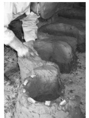
図 11 約 10cm ずつ積み上げる
