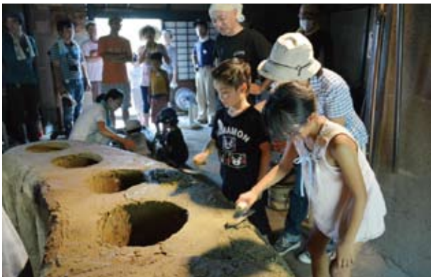
39 表面仕上げ塗り (2015.08.08 ワークショップ 6日目 表面仕上げ)
