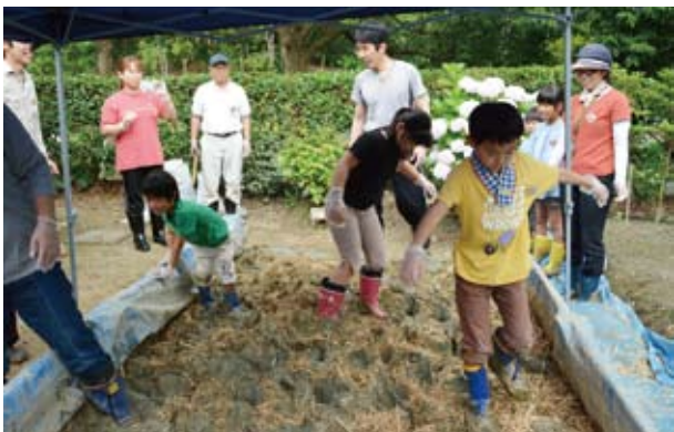
25 泥団子づくり 新しいワラスサを加えて最後に捏ねる (2015.07.04 ワークショップ4日目 土積み上げ)
