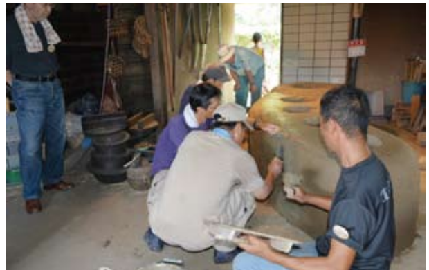
40 表面仕上げ塗り (2015.08.08 ワークショップ 6日目 表面仕上げ)
