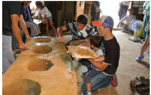
38 表面仕上げ塗り (2015.08.08 ワークショップ 6日目 表面仕上げ)
