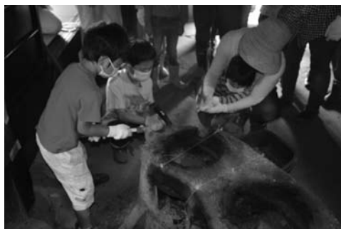
図22 初代かまどの解体
