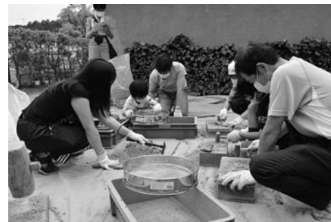
図23 解体した土を細分して再利用できる土へ
