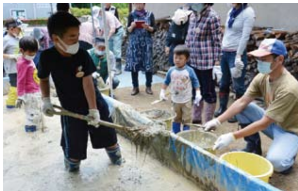
22 土づくり 表面仕上げ用の土の分離、フネから取り出す (2015.06.06 ワークショップ3日目 土づくり)
