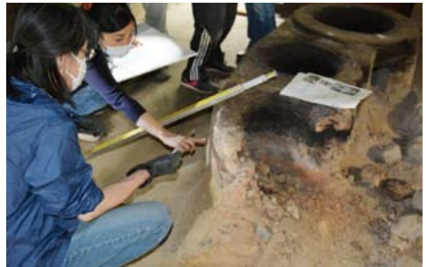
14 調査 解体作業を中断し断面を調査 (2015.05.23 ワークショップ1日目 解体・土づくり)
