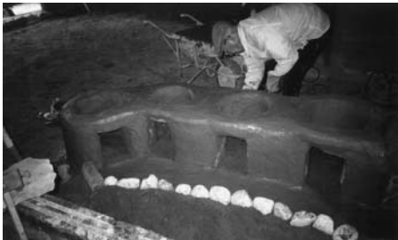
図14 仕上げ用の土で表面を整える
