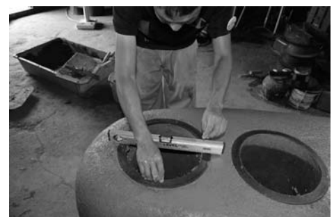
図33 鍋釜の掛け口の調整
