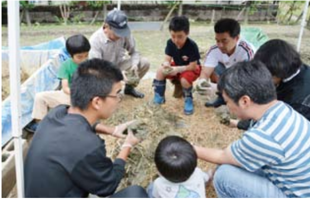
27 泥団子づくり ワラスサを混ぜながら泥団子を作る (2015.07.05 ワークショップ5日目 土積み上げ)
