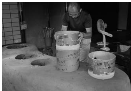
図37 躯体の乾燥後、中型を外す
