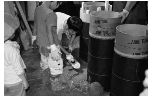
図28 中型のまわりに泥団子を積み上げて成型
