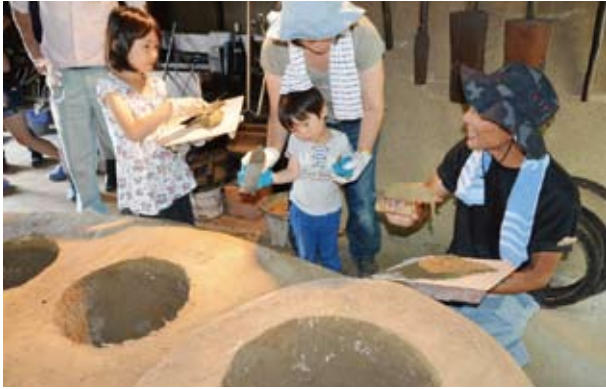
35 表面仕上げ塗り 仕上げ用土を鋁板に取り金鋲で塗りつけ (2015.08.08 ワークショップ 6日目 表面仕上げ)
