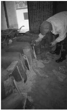
図13 瓦を芯に焚口を作る
