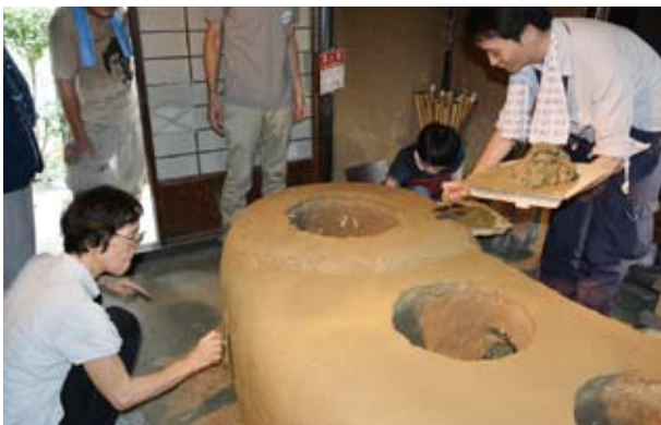
41 表面仕上げ塗り (2015.08.08 ワークショップ 6日目 表面仕上げ)
