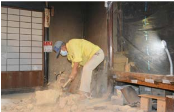
15 解体 最後の一打 (2015.05.24 ワークショップ2日目 解体・土づくり)
