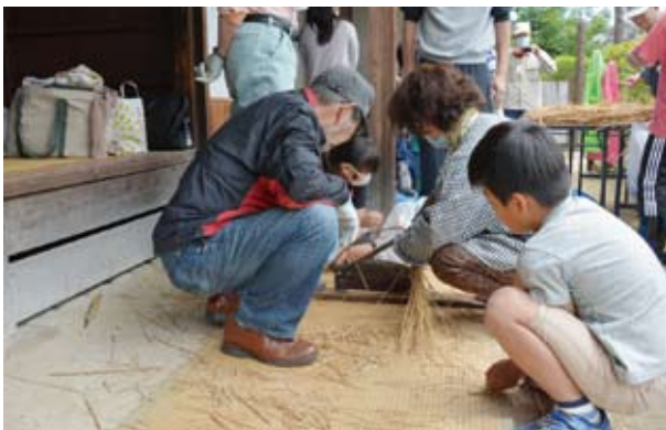
17 ワラスサづくり 古畳の藁は押し切りで細分しワラスサに (2015.06.06 ワークショップ3日目 土づくり)
