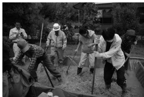
図21 実行委員会による土づくり作業（フネのなかでの土捏ね）
