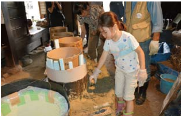
31 土積み上げ 積み上げた土は手や木鋏でならして成型 (2015.07.05 ワークショップ5日目 土積み上げ)
