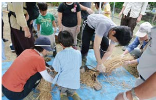
24 泥団子づくり 積み上げ用の土に加えるワラスサづくり (2015.07.04 ワークショップ4日目 土積み上げ)
