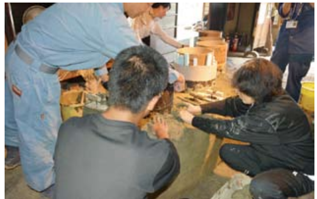
32 土積み上げ 積み上げた土は手や木鋏でならして成型 (2015.07.05 ワークショップ5日目 土積み上げ)
