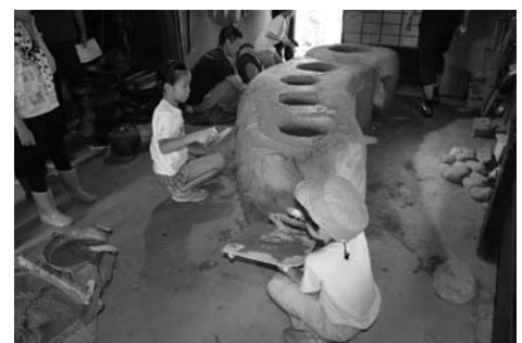
図32 表面の仕上げ塗り
