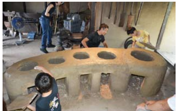
42 表面仕上げ塗り (2015.08.08 ワークショップ 6日目 表面仕上げ)
