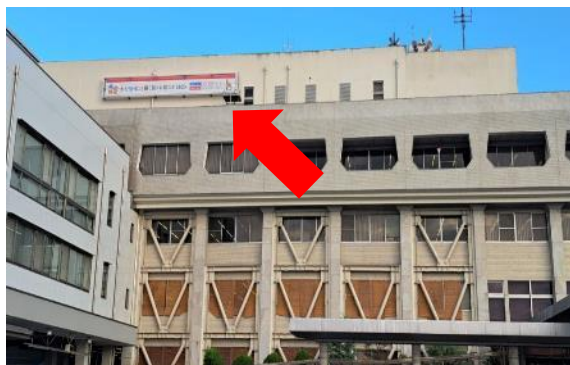
栗東市役所（令和6年9月設置）
