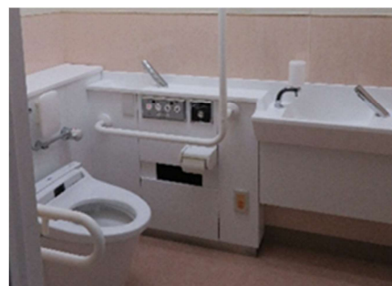
多目的トイレ
