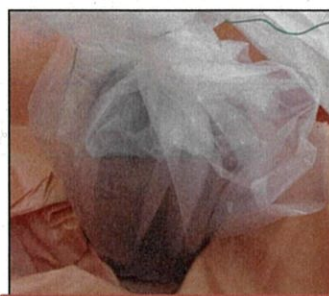
整理作業中に油の漏洩を発見したのでビニール袋(2重)および内袋付きフレコンバッグに梱包
