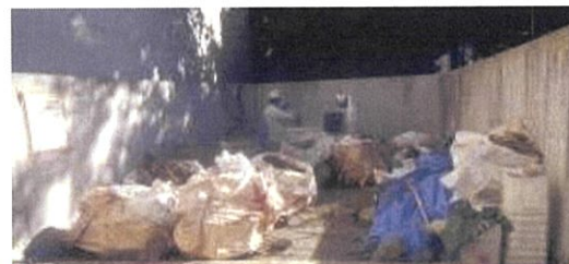
内袋付きフレコンバッグに梱包して危険物ヤードに保管中
