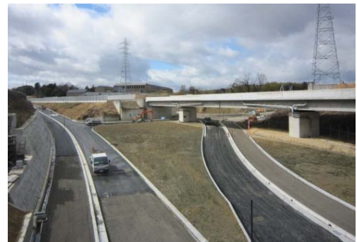
整備中の国道1号バイパス
