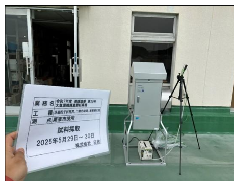
栗東市役所 屋上
