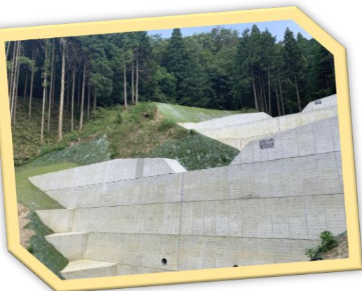
・滋賀県優良工事表彰 奨励賞受賞 令和2年度 第44号 復旧治山工事
