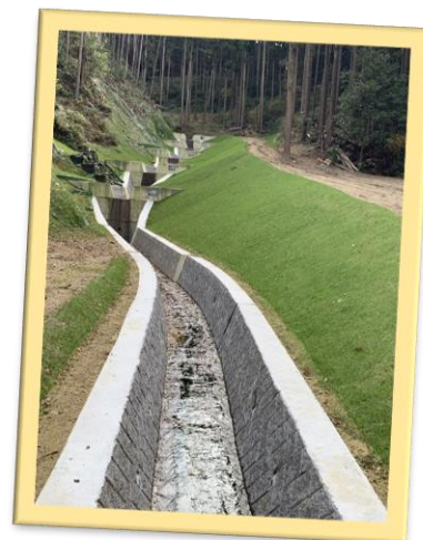
・令和3年度 滋賀県林業協会 治山および林道工事コンクール 会長賞受賞 令和元年度 第2号復旧治山工事
