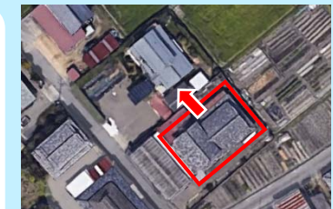
隣に居住している家屋があり、倒壊した際に、周囲への影響が大きい。
