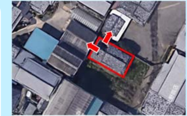
隣に居住している家屋があり、倒壊した際に、周囲への影響が大きい。
