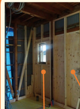
採光等を確保しつつ地震に耐える壁設置
