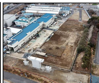
アスベスト混じり土 撤去完了（七間場）
