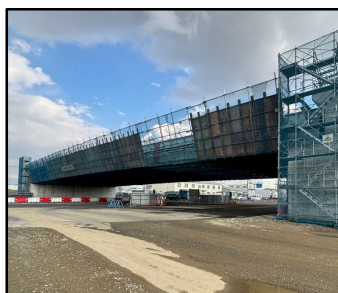
県道片岡栗東線付近 （大橋3号橋）
