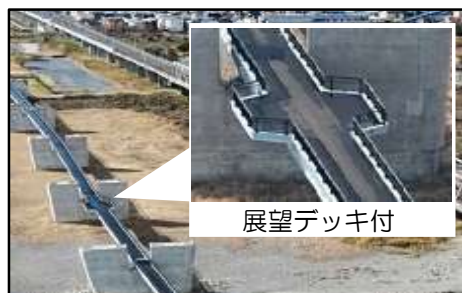
野洲川を渡河する橋梁
