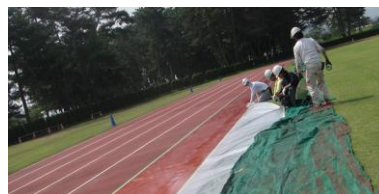
陸上競技場改修工事
