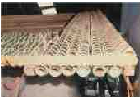
[写真 3-35] 米蔵修理中 軒先螻羽下地、昭和 62 年（1987）
