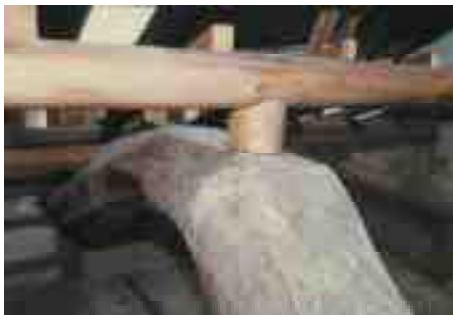
[写真 3-34] 米蔵修理中 棟木・棟束取替、昭和62年（1987）
