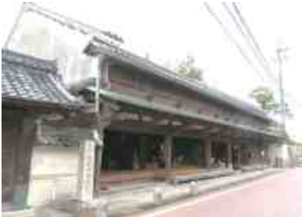
[写真 3-1] 主屋 街道より
