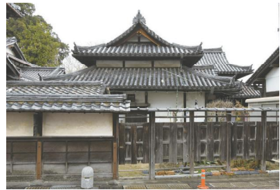
〔写真 4-60〕 隠居所 (外観) (街道より)
