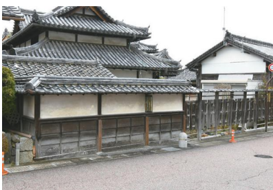
〔写真 4-67〕 築地塀 (南西)
