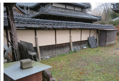
〔写真 4-69〕 築地塀 (中央) (東より)
