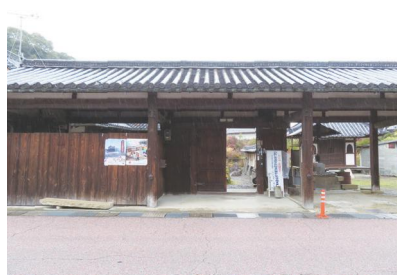
〔写真 4-65〕 馬繋ぎ (隠居所門部分) (東より)
