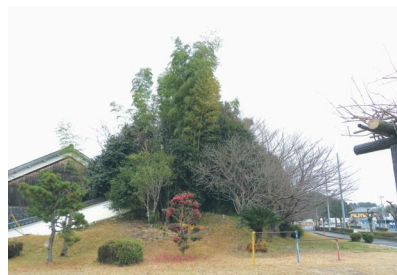
[写真 4-53] 旧葉山川堤防
