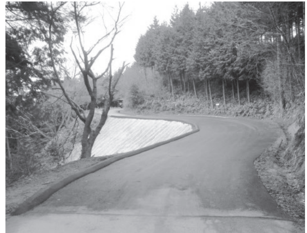
▲林道災害復旧事業 工事完了後
