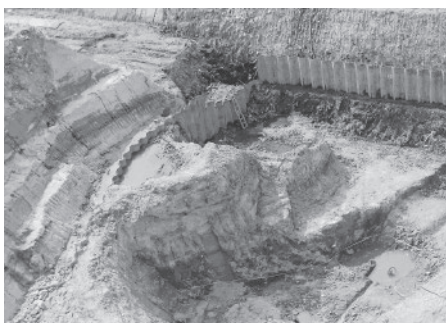
▲旧RD最終処分場工事現場
