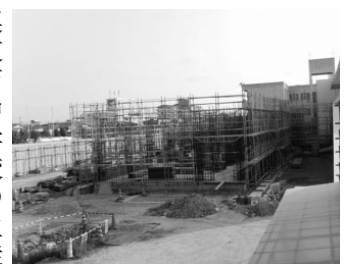
1,000人規模への増築工事
