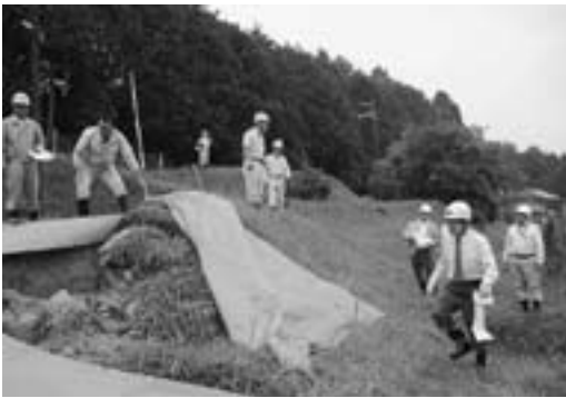
農地法面復旧工事の現場（荒張地先）
