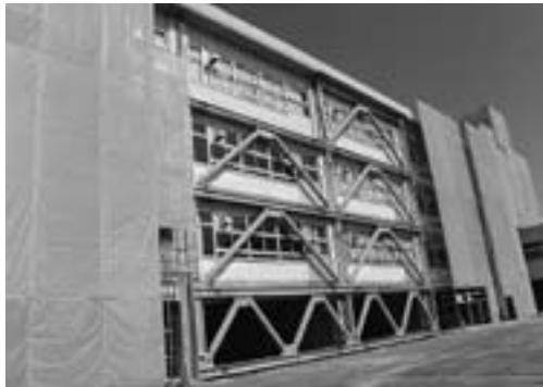
耐震工事の現場（栗東中学校）
