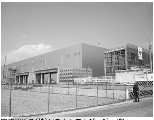
完成間近の(株)リチウムエナジージャパン
