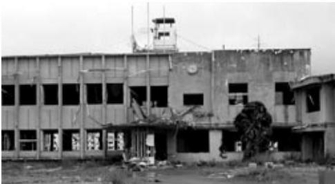
震災により被害をうけた建物
