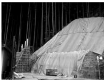
土砂災害警戒区域 法面補強工事
