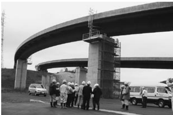
国1バイパス工事現場
