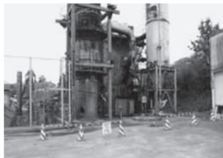
焼却炉支障物撤去
