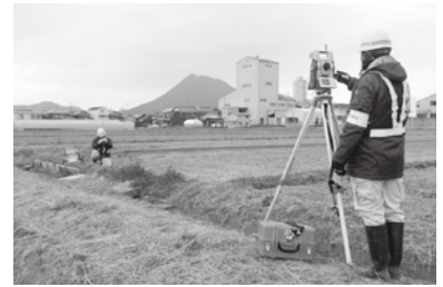
▲国道8号野洲栗東バイパス幅杭設置作業
