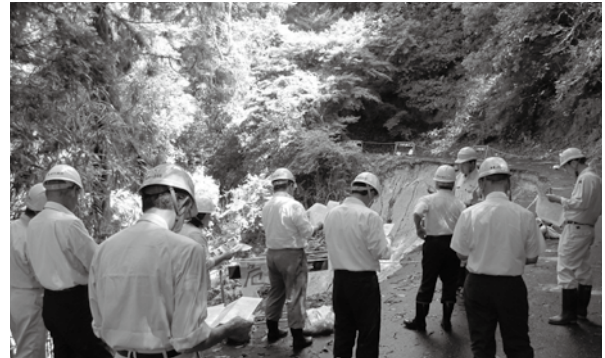
金勝林道崩落現場
